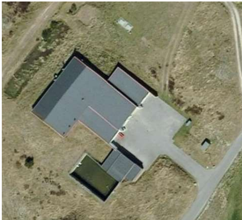
Figur B-1-0-1 viser Fanø Vandværk ovenfra 2022
